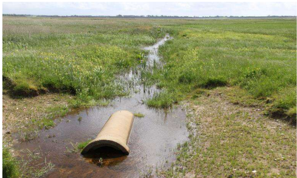
Figur 14: Afvandingssystem 3b ved projektgrænsen og set mod øst. I forgrunden resterne af en røroverkørsel.
