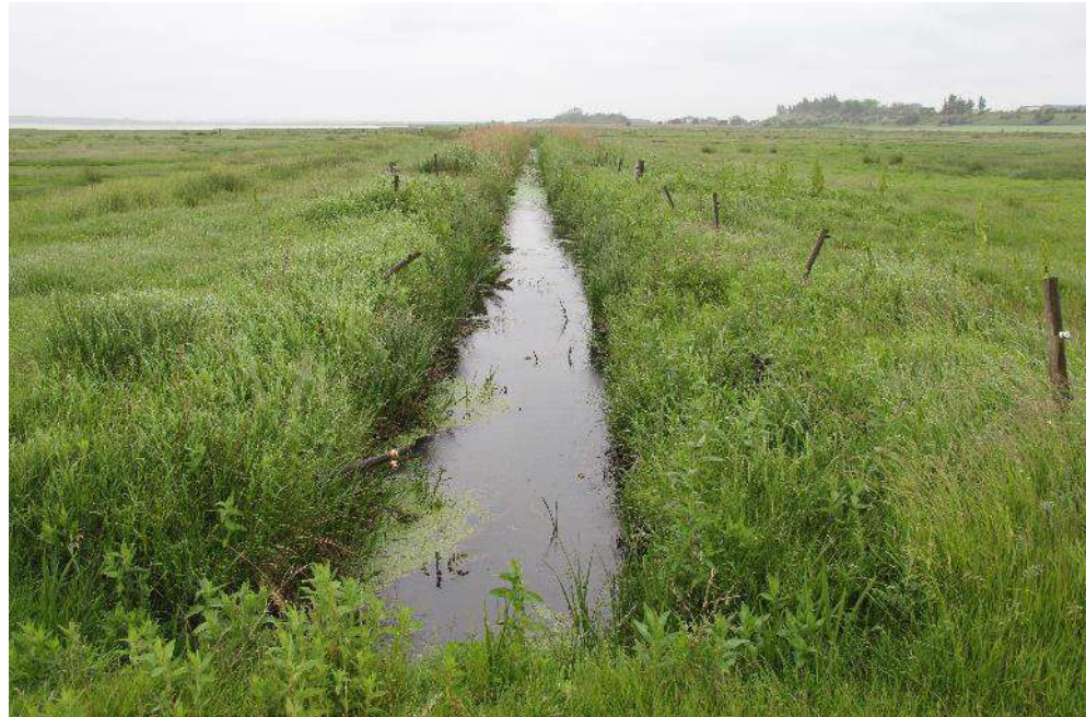
Figur 42: Hovedafvandingskanalen i afvandingsystem 33 set mod nordøst fra projektgrænsen.
