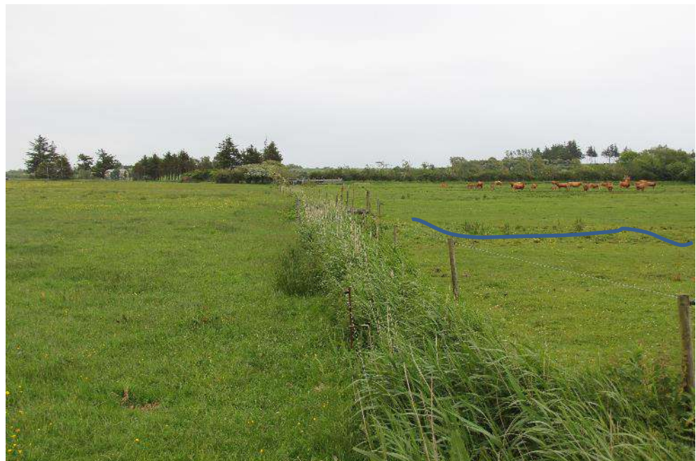
Figur 35: Grøften i afvandingssystem 25. Den blå linje viser terrænspring på ca. 0,5 m med en vis vælddannelse.
